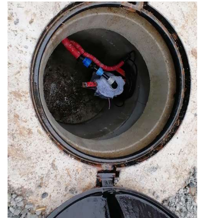
Regard de forage
